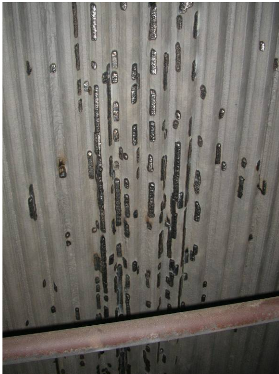
Abbildung 4: Schweißplattierte Membranwand nach Pflegemaßnahme
