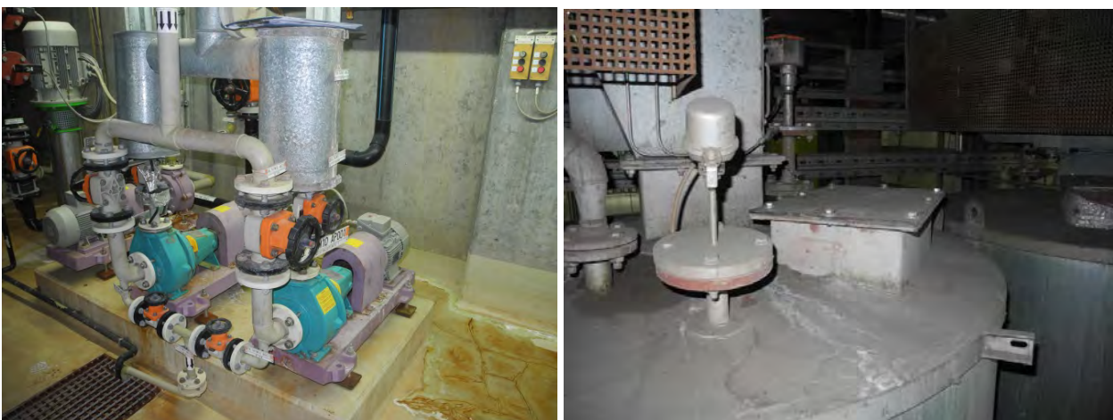
Probenahmestellen Rückstandsproben: Probenahmestelle 7 Waschwasser (links); Probenahmestelle 6 Aktivkohle (rechts).
